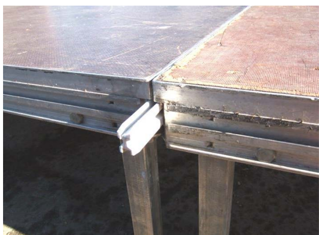
Fissazione dei pezzi di sostegno
